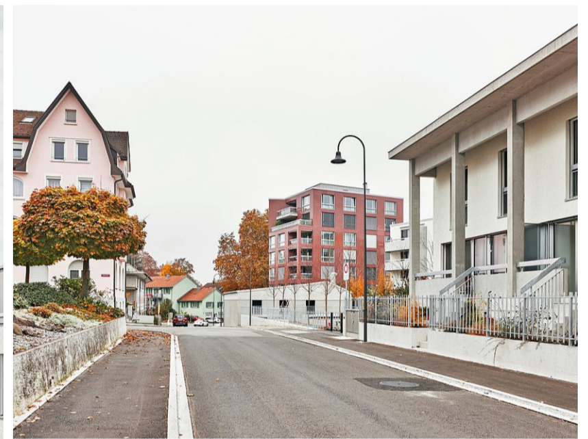
Zahlreiche Stützen und winzige Vorgärten prägen das zweite Gebäude
